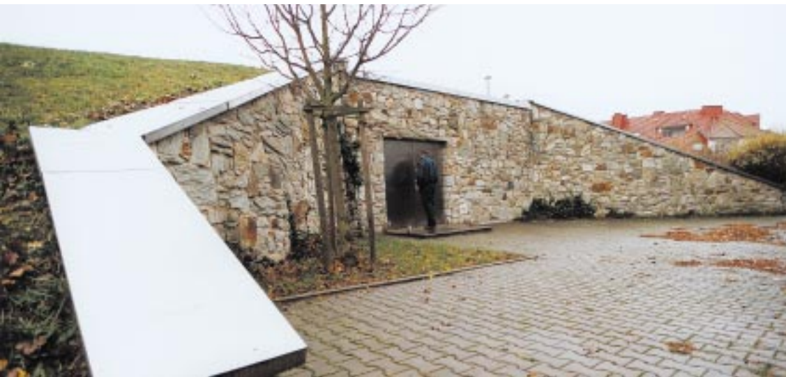
Außenansicht des Hochbehälters in Wicker
