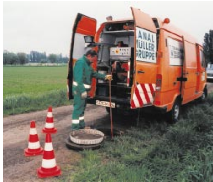
Die Kanäle werden mit einer fahrbaren Videokamera kontrolliert
